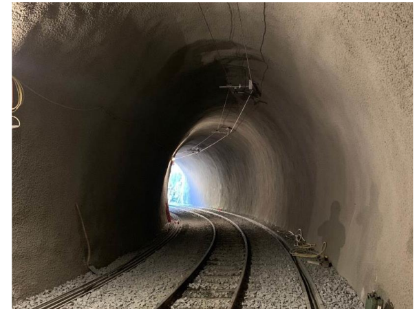
Assainissement du tunnel des Marécottes.
