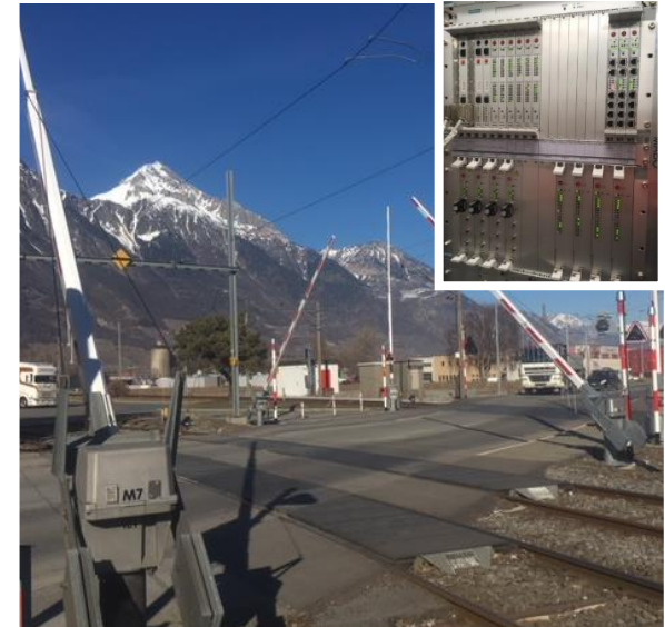
Passage à niveau des Finettes – Block de ligne TMN.
