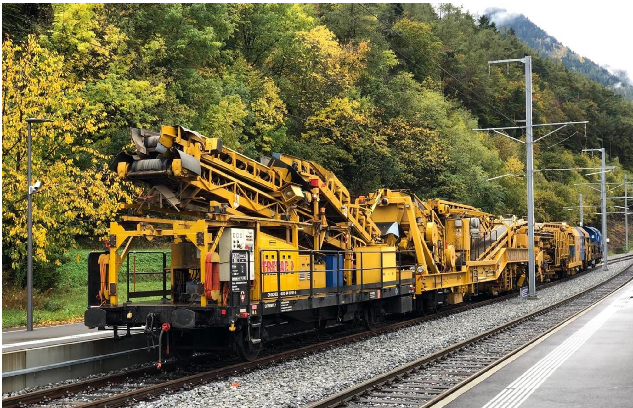
Train de chantier pour l'assainissement des voies.
