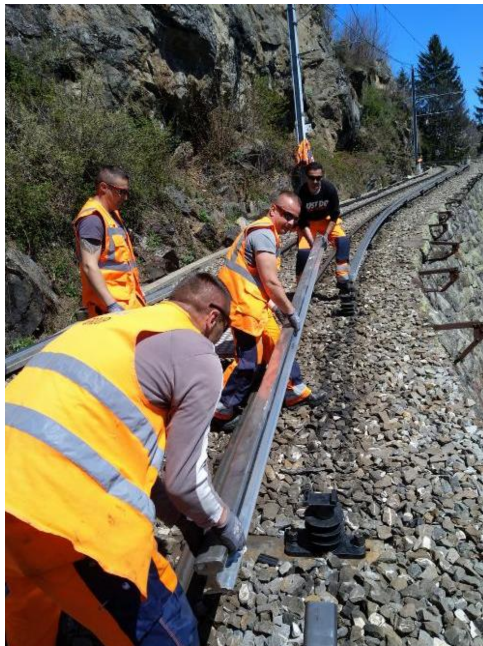
Montage prototype nouveau 3 ème rail alu.
